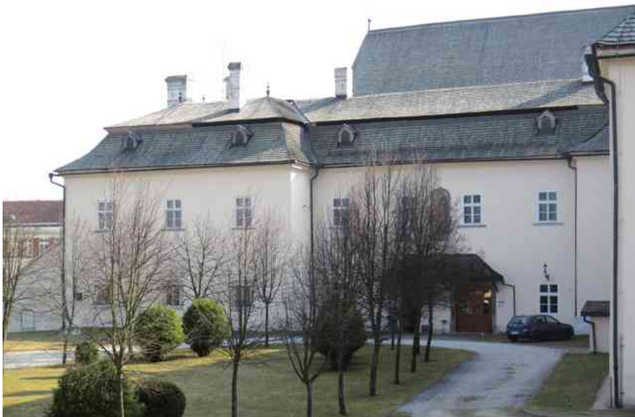
Obr. 48 Pohľad na severné priečelie biskupskej rezidencie - prízemie vystupujúcej časti budovy naľavo je Mutimírov palác.
