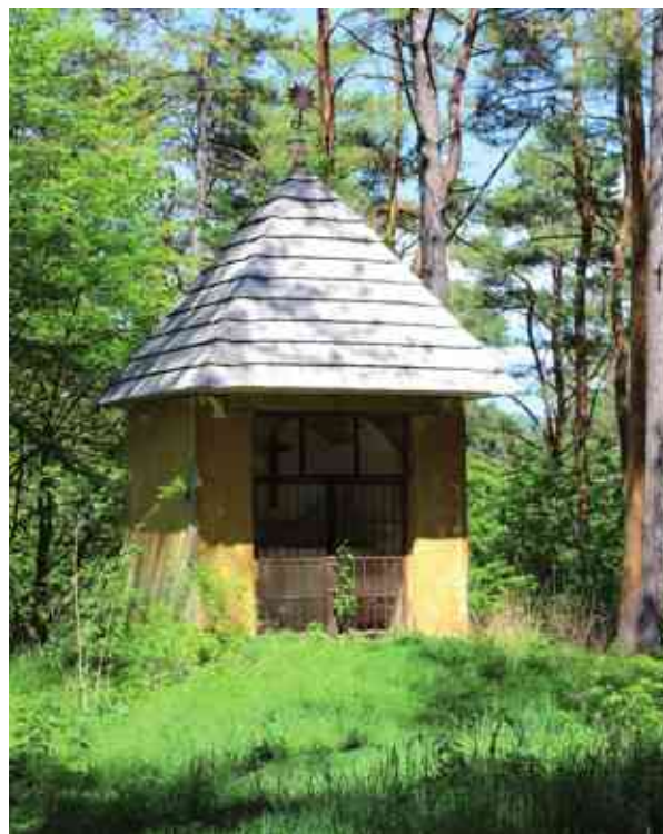
Obr. 34 Kaplnka sv. Františka Xaverského (1669), ktorú postavil prepošť Báršoň. V kalvárii predstavuje sídlo Piláta Pontského.
